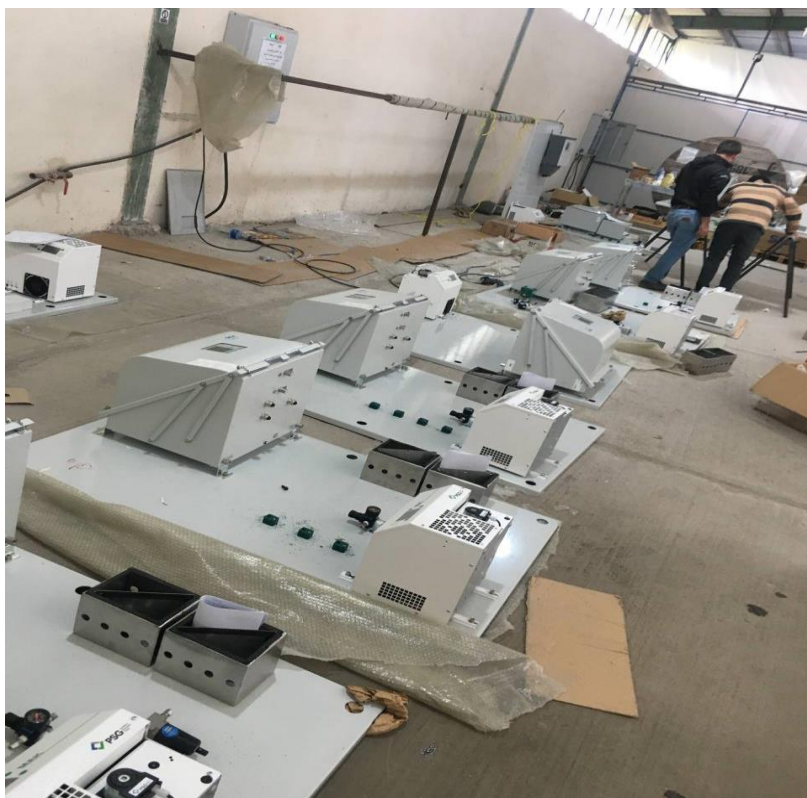
پلیت‌ها قبل از تیوب کاری و کابل کشی
